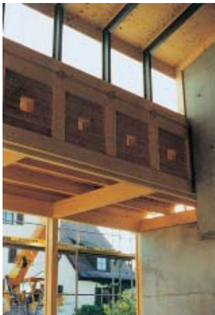
Bild 8: Die auf dem Obergurt des Längsträgers aufgeständerten Stahlrahmen bilden die Dachlaterne.
