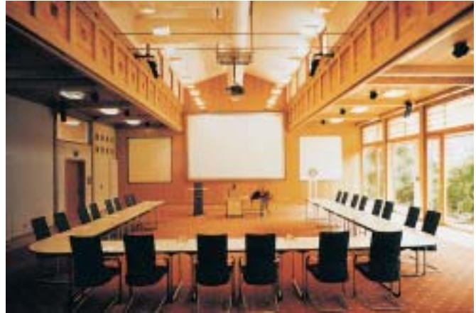
Bild 10: Zugbänder aus Rundstahl in Höhe des Trägerobergurtes halten die Rahmenspreizkräfte im System.
