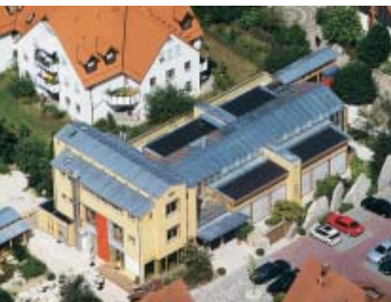
Bild 2: Der dreigeschossige Kopfbau liegt rechtwinklig zum gläsernen Längsschiff des Tagungsraumes.
