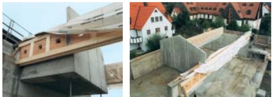
Bild 6 links, Bild 7 rechts: Der kleine Gruppenraum ragt zwischen den Längsträgern wie eine Schublade in das Längsschiff (Bild 6: Ansicht von unten, Bild 7: Ansicht von oben). Stahlbetonwände dienen als Endauflager für die Längsträger.
