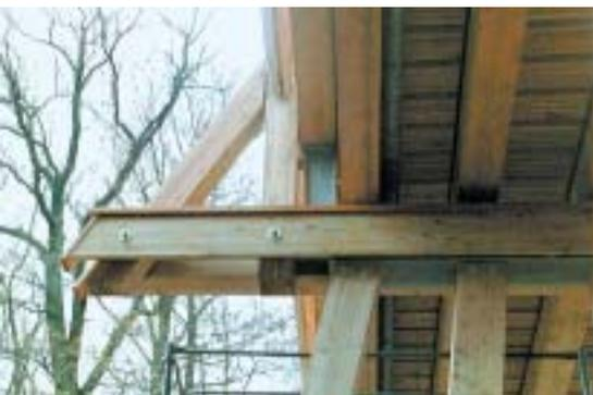
**Bild 8:** Brückenuntersicht mit Blick von unten auf das Schrammbord. Konstruktiver Holzschutz: Abgeschrägte Zangenenden und zusätzliche Abdeckungen.
