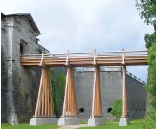
**Bild 1:** Die Gehbahn der neuen Brücke ruht auf vier Brückengliedern, die sich nach unten auffächern.
