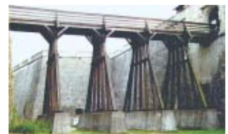
**Bild 3:** Die zum Zeitpunkt der Untersuchung etwa 30 Jahre alte Brücke war durch Innenfäule verschiedener Tragglieder nicht mehr standsicher.
