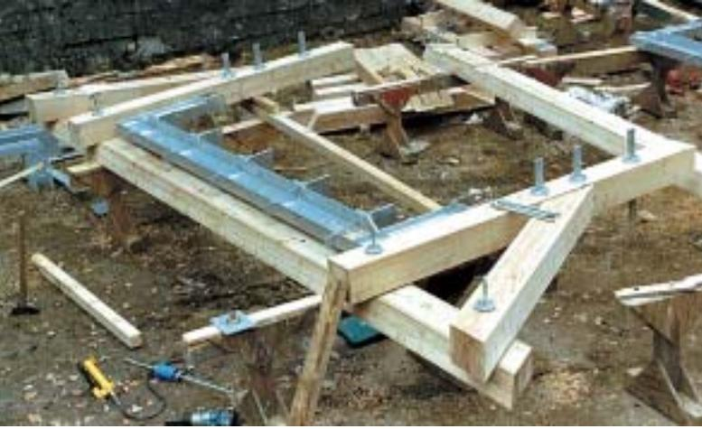
**Bild 4:** Vormontage: Geländerpfosten, Pfostenabstreben sowie ein Teil der Zange werden am Halbrahmen aus Stahl angeschlossen.
