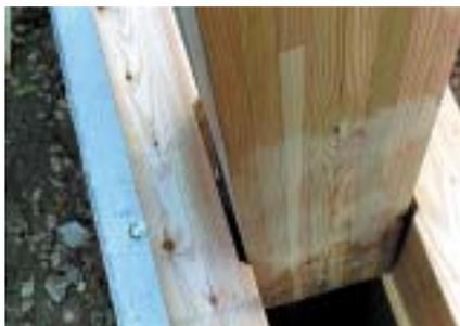
**Bild 16:** Anschluss sich kreuzender Querschnitte.
