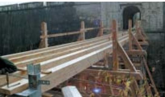
**Bild 7:** Die Hirnenden der 25 m langen Längsträger schließen an gekröpfte Rahmenkonstruktionen der Endauflager.
