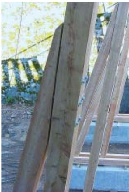
**Bild 15:** Anschluss einer queraussteifenden Jochstrebe an die äußere Jochstütze ohne Berührungsfläche. Die Strebe erhält später eine Blechabdeckung
