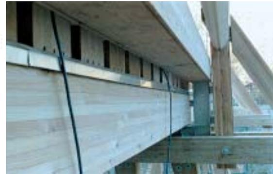
**Bild 14:** Der Tragbelag wird oberhalb der Längsträger mit einem lichten Abstand von 6 cm verlegt. Für die Querbelüftung erhielten die Balken unterseitig Nuten.
