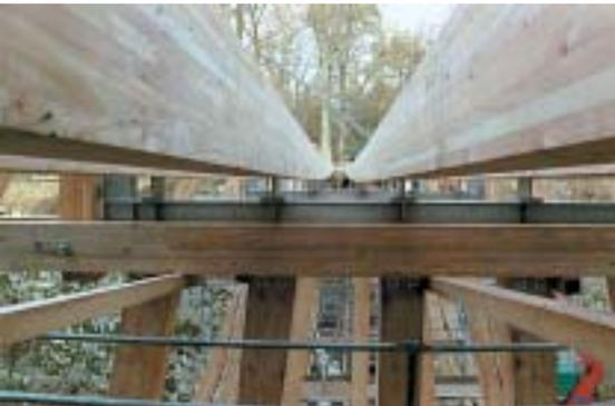
**Bild 6:** Blick auf die Zangenkonstruktion mit dazwischen liegendem Halbrahmen und Anschlussbleche für die Längsträger.
