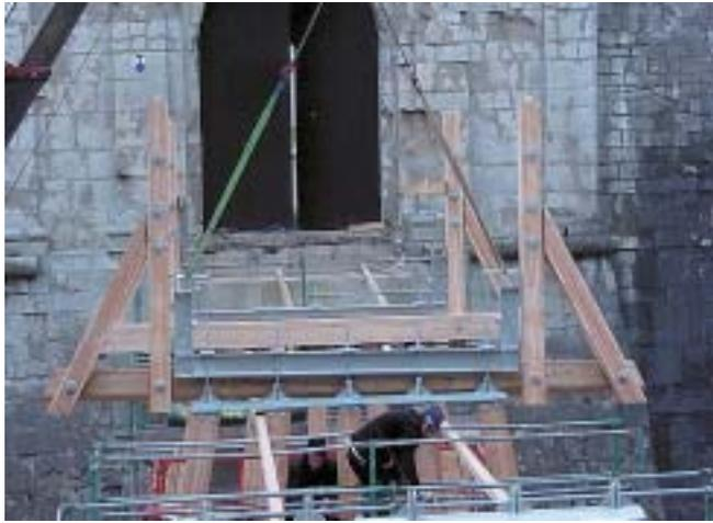
**Bild 10:** ... vormontierten Halbrahmen (siehe Bild 4), die auch die Geländerkonstruktion tragen. Nach der Montage kann die Zange geschlossen werden.
