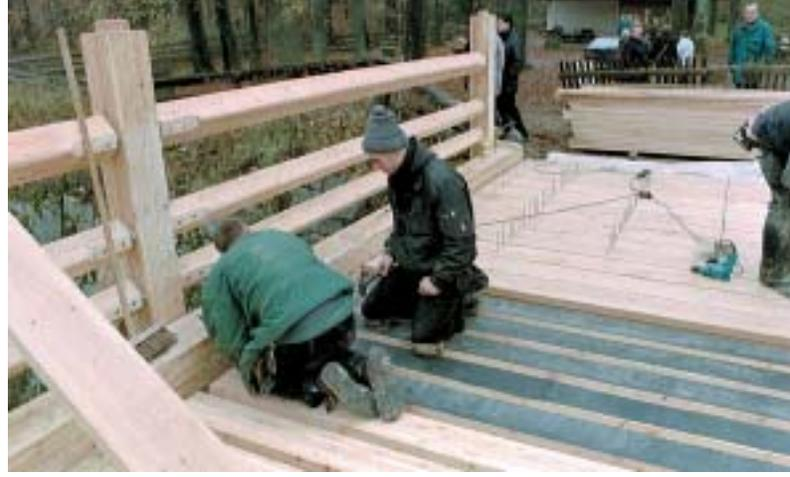
**Bild 12:** Aufbringen des Verschleißbelags auf den Tragbelag mit dazwischen liegendem Dichtungsgummi. Das Schrammbord sitzt als losgelöstes Element neben der Gehbahn, wodurch auch Fäule gefährdete Berührungsflächen vermieden werden.
