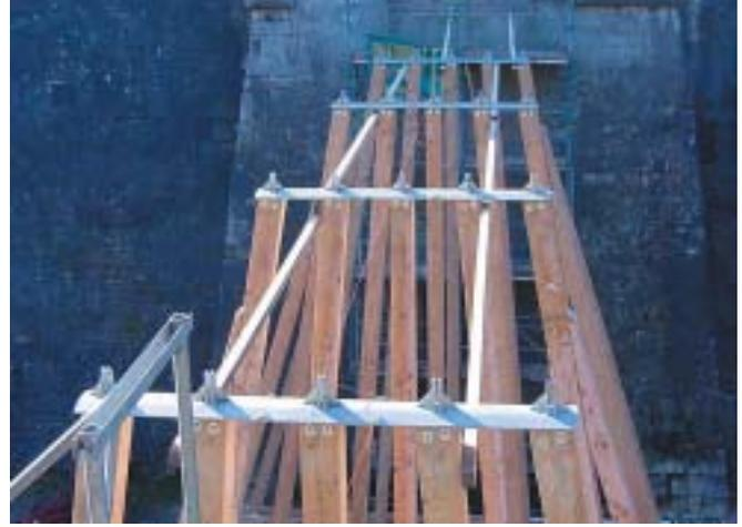
**Bild 5:** Ein verzinktes Stahlelement aus gekantetem Blech mit ober- und unterseitigen Anschlussstellen, verbindet die Joche mit den ... (weiter siehe Bild 10)
